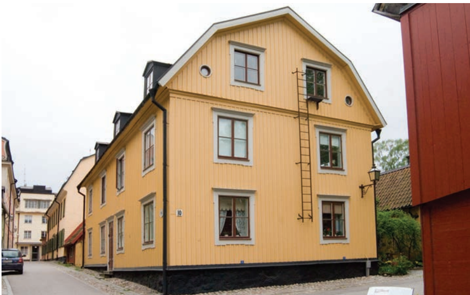
GATHUSET SETT MOT NORDVÄST. FOTO: J. MALMBERG.
