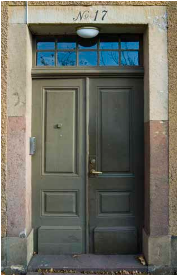
JÄRNVÅGSHUSETS PORTAR HAR OMFATTNINGAR AV SANDSTEN OCH PARDÖRRAR FRÅN 1700-TAL ELLER 1800-TALET'S BÖRJAN. ÖVERLJUSFÖNSTREN ÄR FRÅN 1700-TALET'S MITT MED TIDSTYPISKA TÄRNINGAR I SPRÖJSKORSEN. FOTO: J. MALMBERG.
