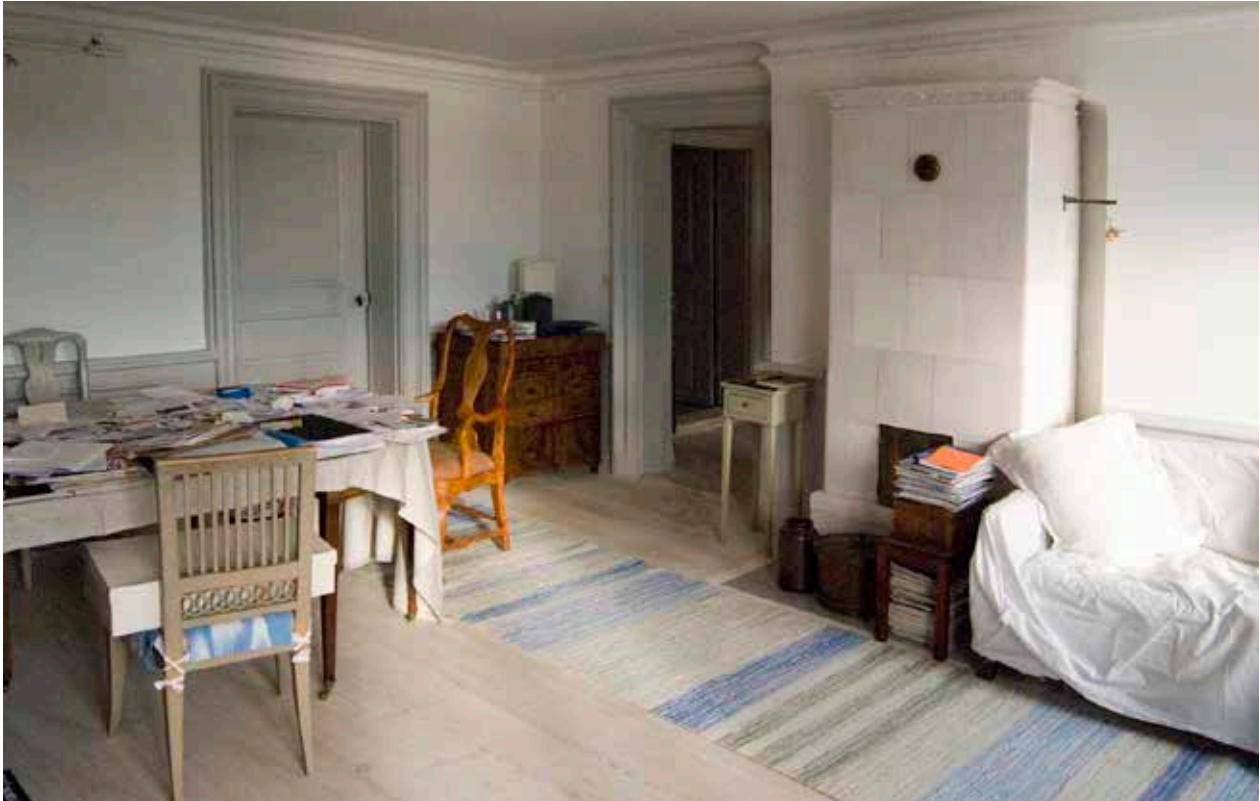
KAKELUGN I JÄRNVÅGSHUSET FRÅN OMKRING 1860. DÖRRFODER, BRÖSTPANEL OCH TAKLIST ÄR BEVARADE FRÅN 1700-TALET. FOTO: J. MALMBERG.
