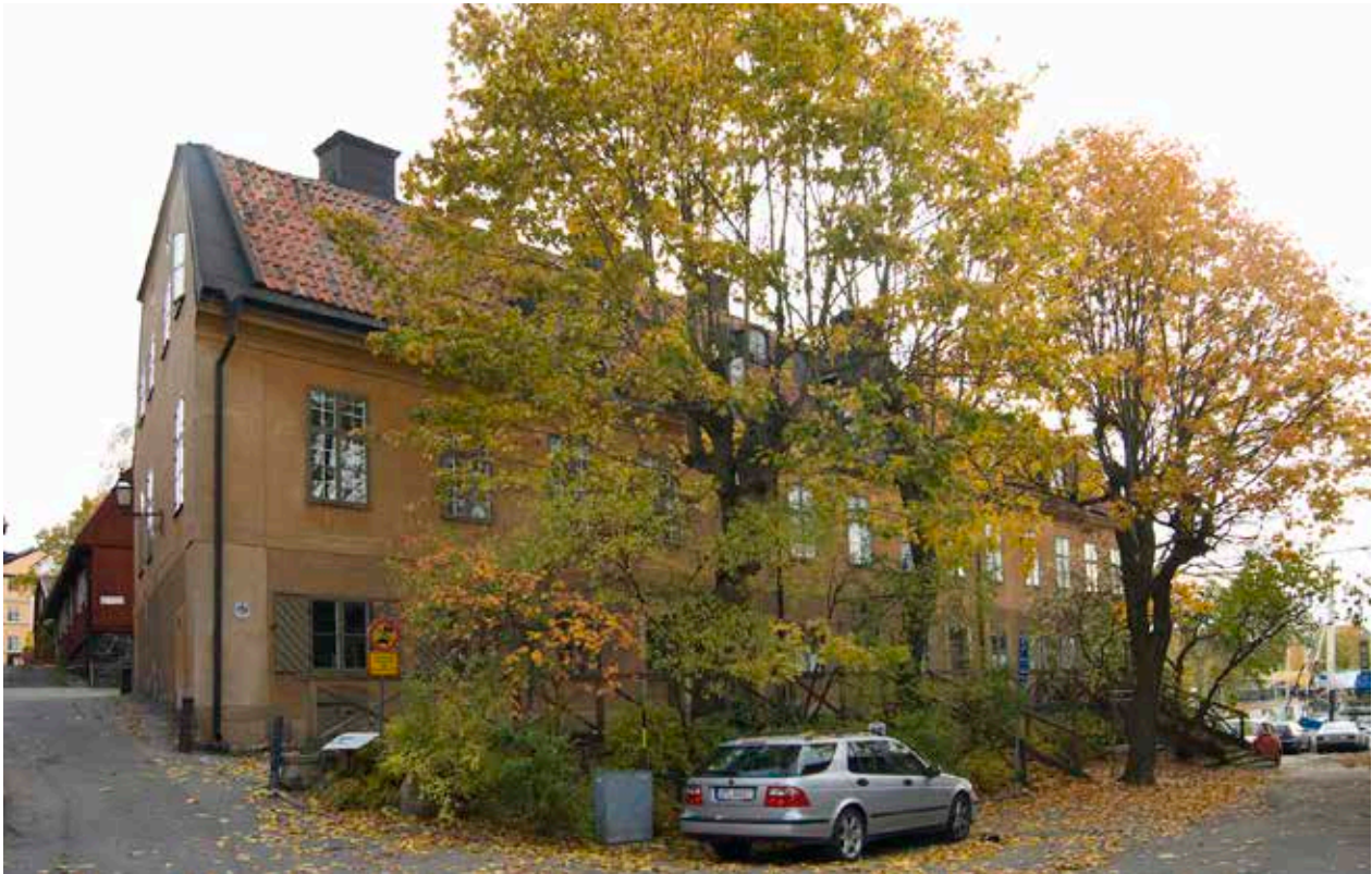
JÄRNVÅGSHUSET SEDD FRÅN NORDVÄST. NORDGAVELN ÄR SNEDSTÄLLD OCH ANPASSAD TILL ÖSTRA VARVSGATANS STRÄCKNING. FOTO: J. MALMBERG.
