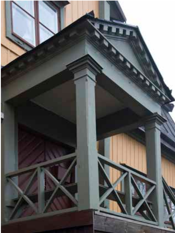
TRÄHUSET ÄR FÖRSETT MED EN FÖRSTUKVIST PÅ VÄSTRA LÅNGSIDAN SOM HAR EN PELARBUREN, TANDSNITTSDEKORERAD FRONTON. FOTO: J. MALMBERG.
