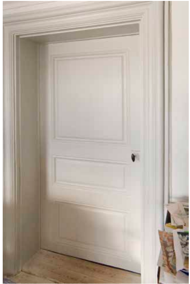
ENKELDÖRR OCH KRAFTIGT PROFILERAT DÖRRFODER I JÄRNVÅGSHUSET. FOTO: J. MALMBERG.
