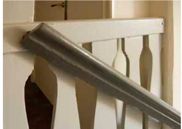
RÄCKE I JÄRNVÅGSHUSET MED KONTURSÅGADE PLANKOR SAMT HANDELDARE I TRÄ, BÅDA FRÅN 1700-TALET. FOTO: J. MALMBERG.
