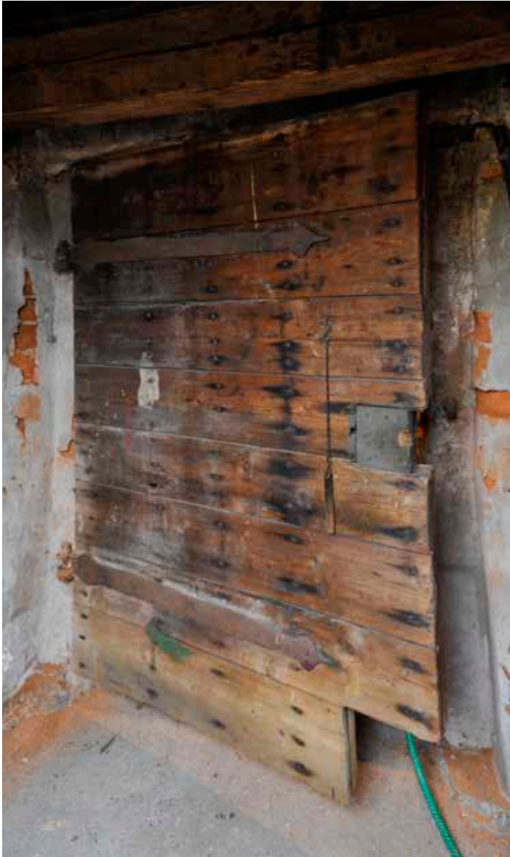
TILL KÄLLAREN LEDER EN ÄLDRE PLANKDÖRR MED BANDGÅNGJÄRN AV 1700-TALSTYP. FOTO: J. MALMBERG.
