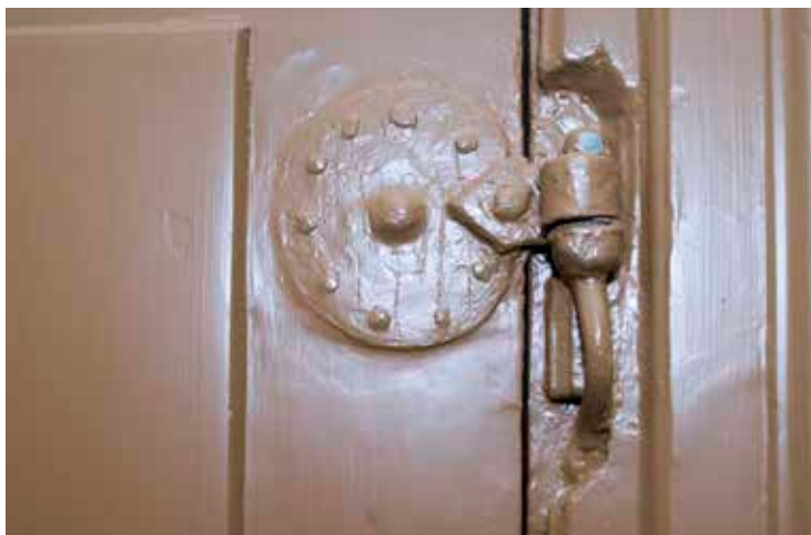
DETALJ AV GÅNGJÄRN OCH BESLAG FRÅN 1700-TALET I JÄRNVÅGSHUSET. FOTO: J. MALMBERG.
