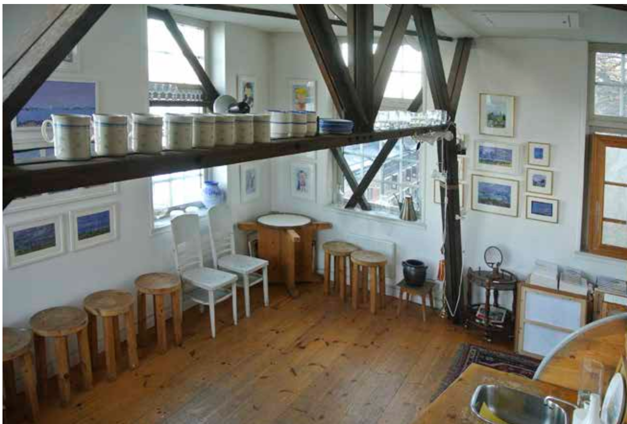
I TAKET HAR DELAR AV HISSENS JÄRNKONSTRUKTION LÄMNATS SYNLIGA. FOTO: J. MALMBERG.
