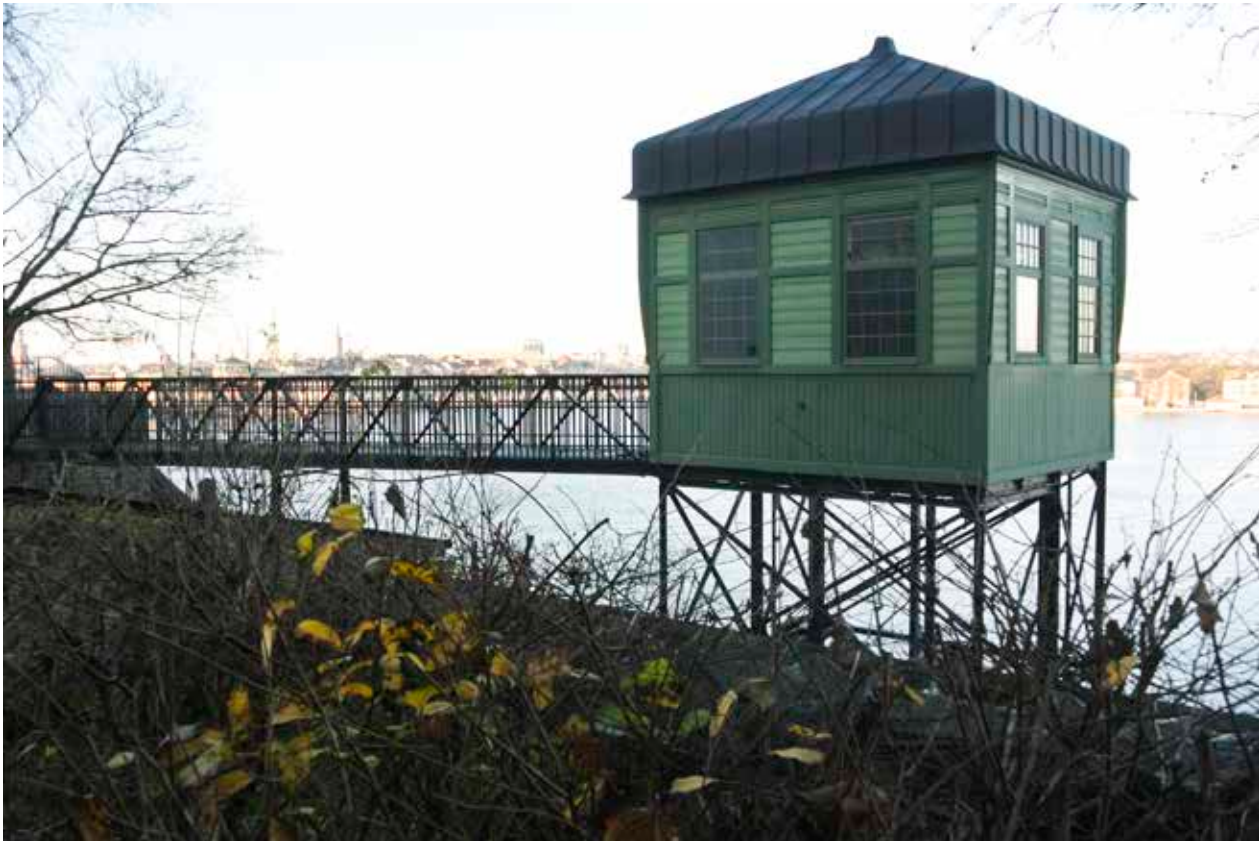
HISSENS ÖVRE DEL HAR ÅTERFÅTT SIN URSPRUNGLIGA FÄRG VID DEN SENASTE RENOVERINGEN. FOTO: J. MALMBERG.
