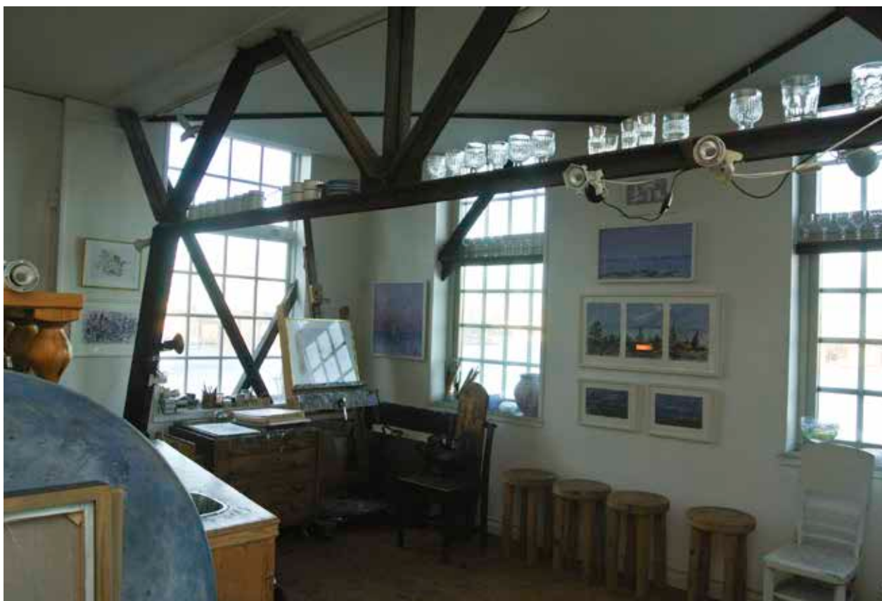
FÖNSTRET TILL VÄNSTER ÄR EN KOPIA AV DE URSPRUNGLIGA, SPRÖJSADE FÖNSTREN. FÖNSTREN TILL HÖGER ÄR VÄNDBARA MED ETT KLUMPIGARE, UTANPÄLIGGANDE SPRÖJSVERK. FOTO: J. MALMBERG.
