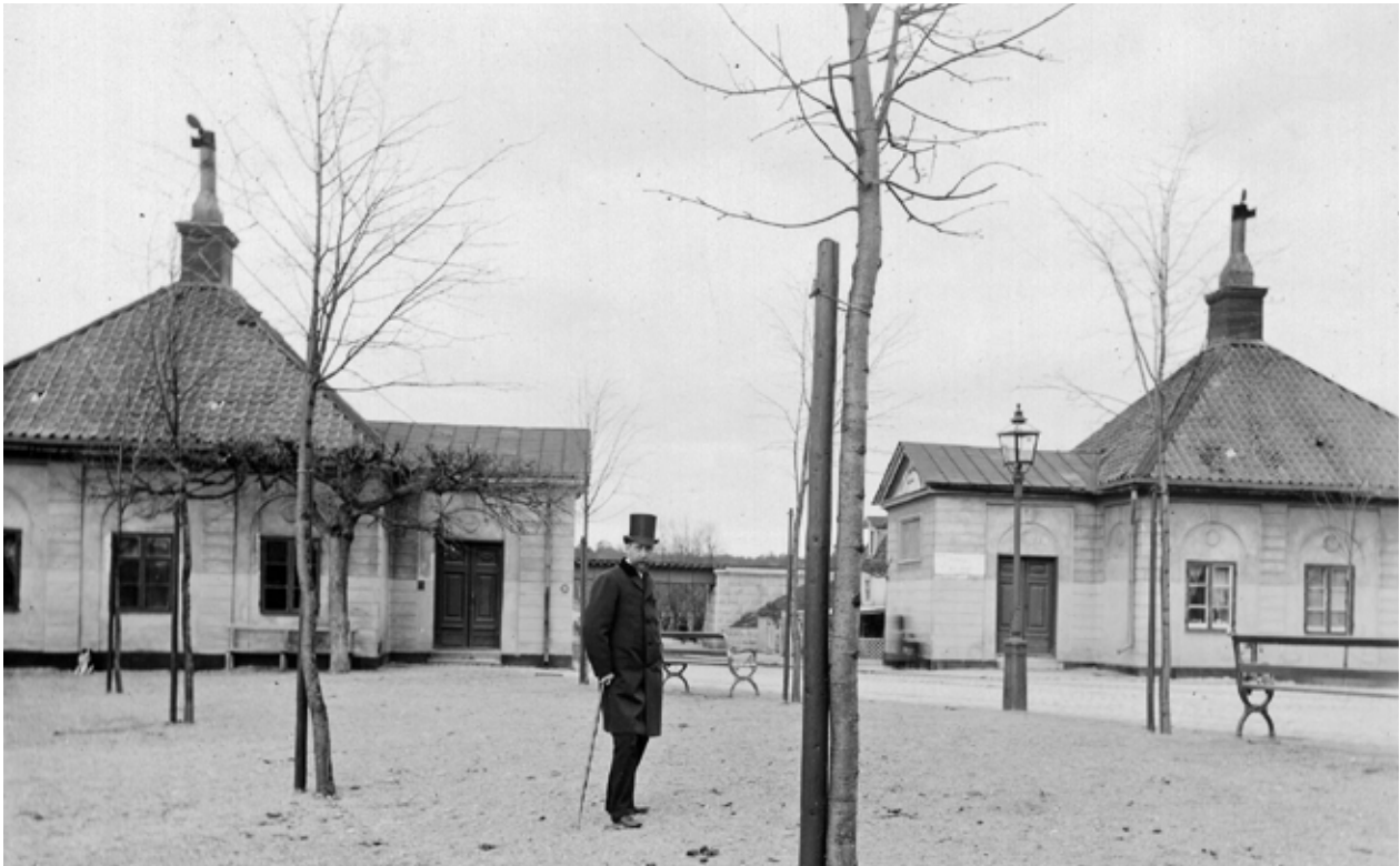
VY NORRUT MOT TULLHUSEN, FRÅN ÅR 1894. URSPRUNGLIGEN BANDS DE TVÅ HUSEN SAMMAN GENOM EN HÖG TRÄPORTAL, SOM I SIN TUR VAR SAMMANBYGGD MED LÄGRE PORTGÅNGAR AV STEN. PÅ BILDEN ÄR TRÄPORTALEN BORTA SEDAN LÄNGE OCH DE UTBYGGDA PORTGÅNGARNA HAR FÅTT NY FUNKTION SOM FÖRSTUGOR TILL TULLHUSEN. UTBYGGNADERNA REVS 1902 I SYFTE ATT BREDDA GATURUMMET FÖR TRAFIKEN. FOTO I SSM:S ARKIV, E9280.
