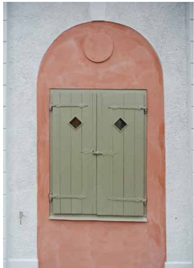
BÄGVALVEN ÄR SLÄTPUTSADE I KONTRAST TILL DE SPRITPUTSADE, GRÅA VÄGGFÄLTEN. OVANFÖR BÄGVALVETS FÖNSTER, PÅ BILDEN TILLSLUTET MED LUCKOR, SITTER ETT PUTSAT CIRKELMOTIV. FOTO J. MALMBERG.
