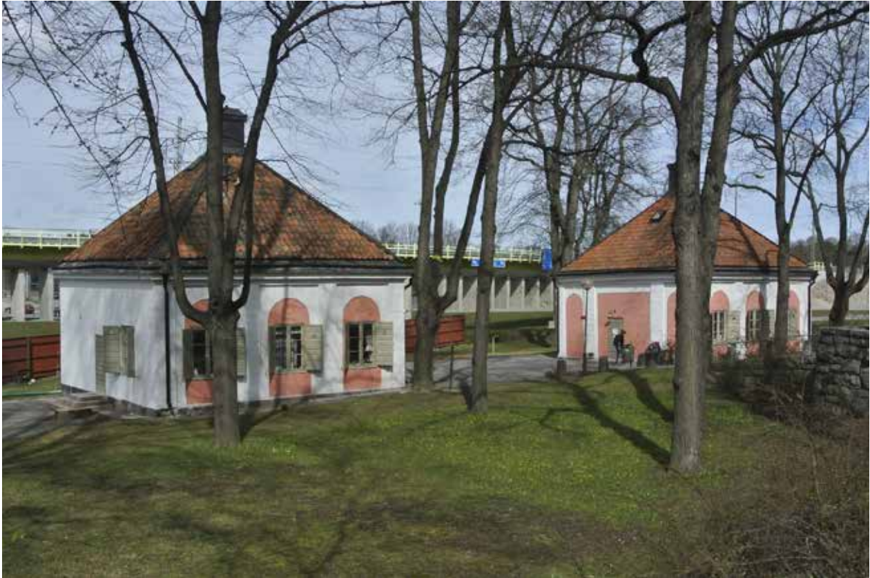
VY MOT TULLHUSEN FRÅN SYDVÄST. DE FASADER SOM VÄNDE SIG MOT TRAFIKANTERNA HAR EN PUTSARKITEKTUR MED RUSTICERADE LISENER OCH BÅGVALV. FASADERNA ÅT MOTSATTA SIDOR VAR MINDRE PÅKOSTADE. FOTO J. MALMBERG.
