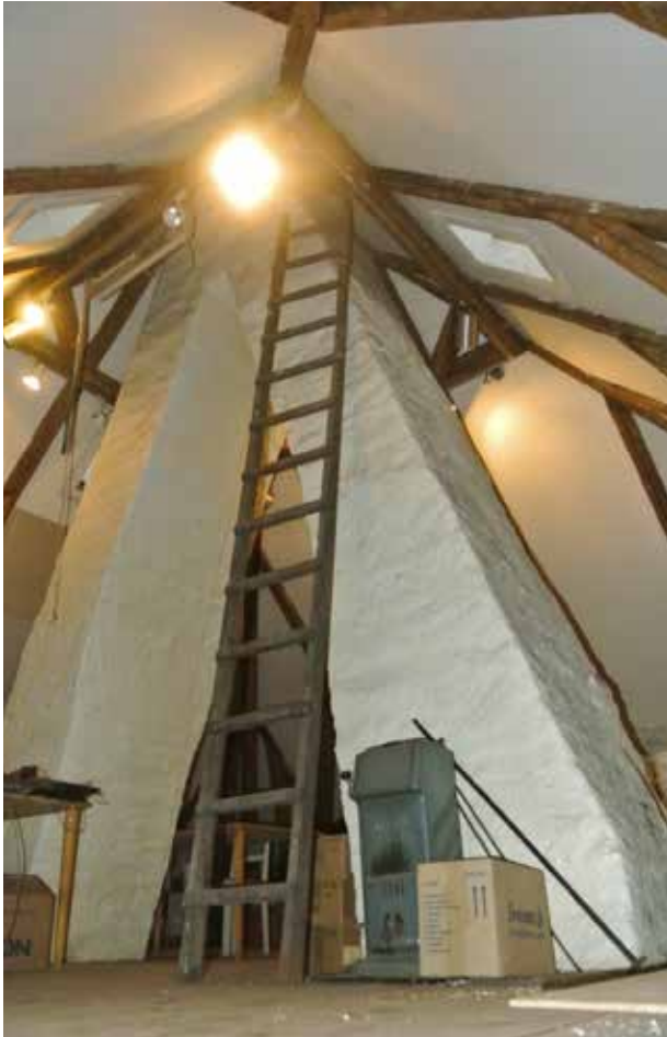
TULLHUSENS HÖGA VINDSPLAN DOMINERAS AV DE MURADE RÖKGÅNGARNA SOM FÖRS SAMMAN TILL EN SKORSTEN I TAKETS NOCK, ETT SÅ KALLAT BYXBEN. PÅ BILDEN DET ÖSTRA HUSETS VINDSPLAN. FOTO J. MALMBERG.
