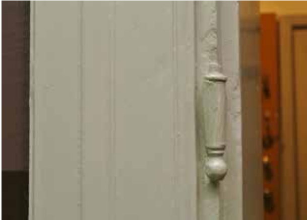
I BÅDA HUSEN ÄR DÖRRFODREN AV SENARE 1700-TALSTYP, DELVIS MED SAMTIDA GÅNGJÄRNSBESLAG. FODREN ÄR SANNOLIKT ÅTMINSTONE DELVIS PASTISCHER EFTER ÄLDRE MODELL. FOTO FRÅN DET ÖSTRA TULLHUSET, AV J. MALMBERG.
