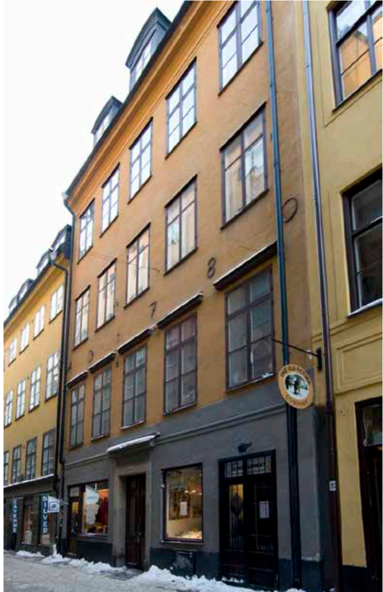
FASADEN ÄR SLÄTPUTSAD I TVÅ FÄRGER. EFTER OMBYGGNADEN 1780 PRYDDES FASADEN MED ANKARSLUTAR DÄR ÅRTALET ANGES. PORTALEN ÄR FRÅN SAMMA OMBYGGNAD. FOTO: J.MALMBERG
