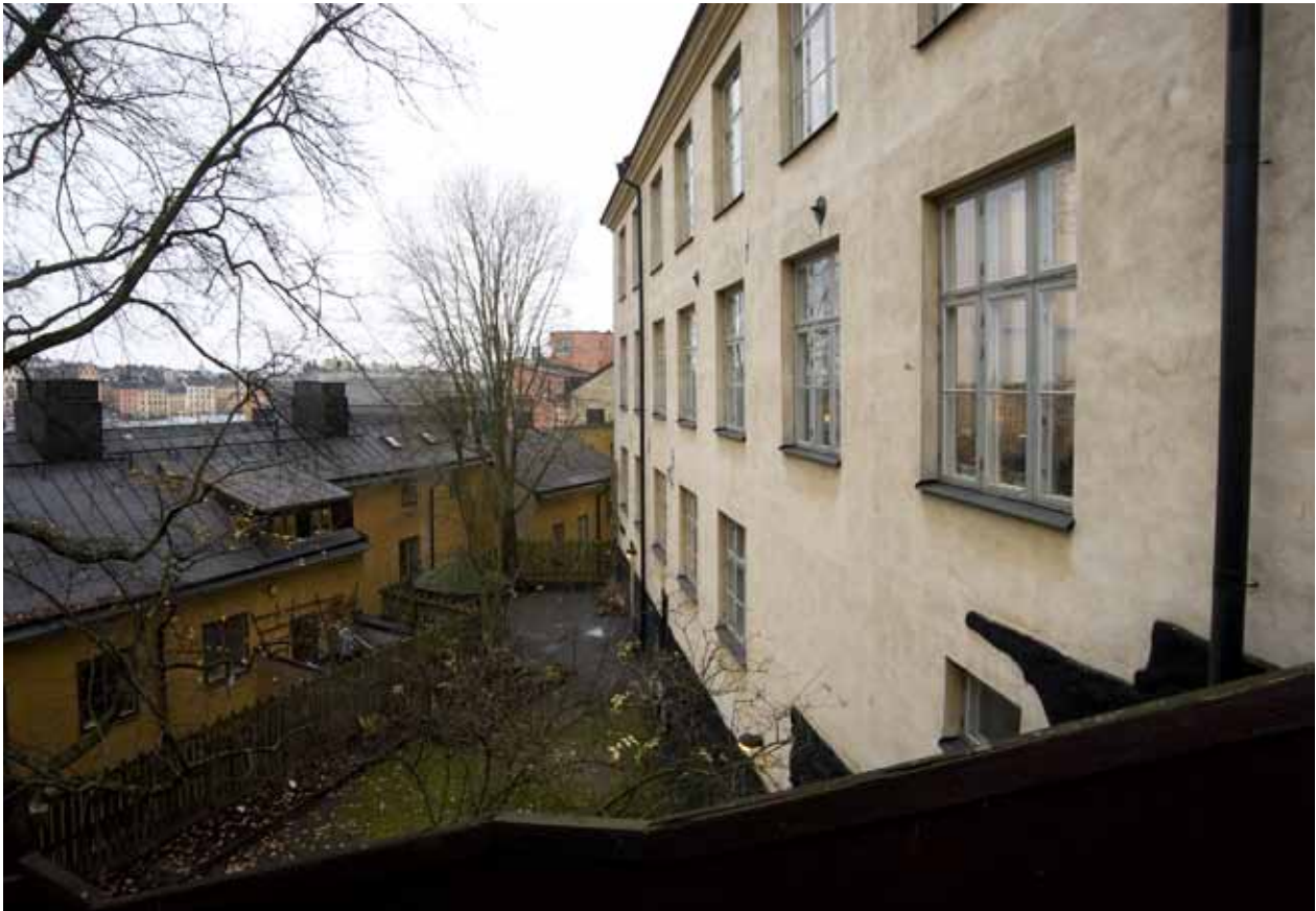
FASADEN MOT NORR MED GÅRDSUTRYMME. FOTO. J MALMBERG.
