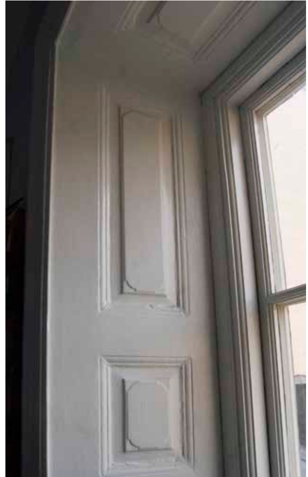
HUS 1. FÖNSTERSMYGPÅNEL MED NUPNA HÖRN, 1700-TAL. FOTO: J. MALMBERG.
