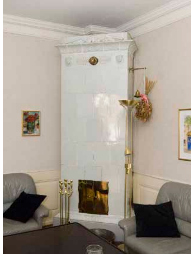
HUS 1. RUMMET HAR PUTSAD TAKLIST OCH HALVFRANSK BRÖST-PANEL. KAKELUGNEN ÄR FRÅN EMPIREN. FOTO: J. MALMBERG.
