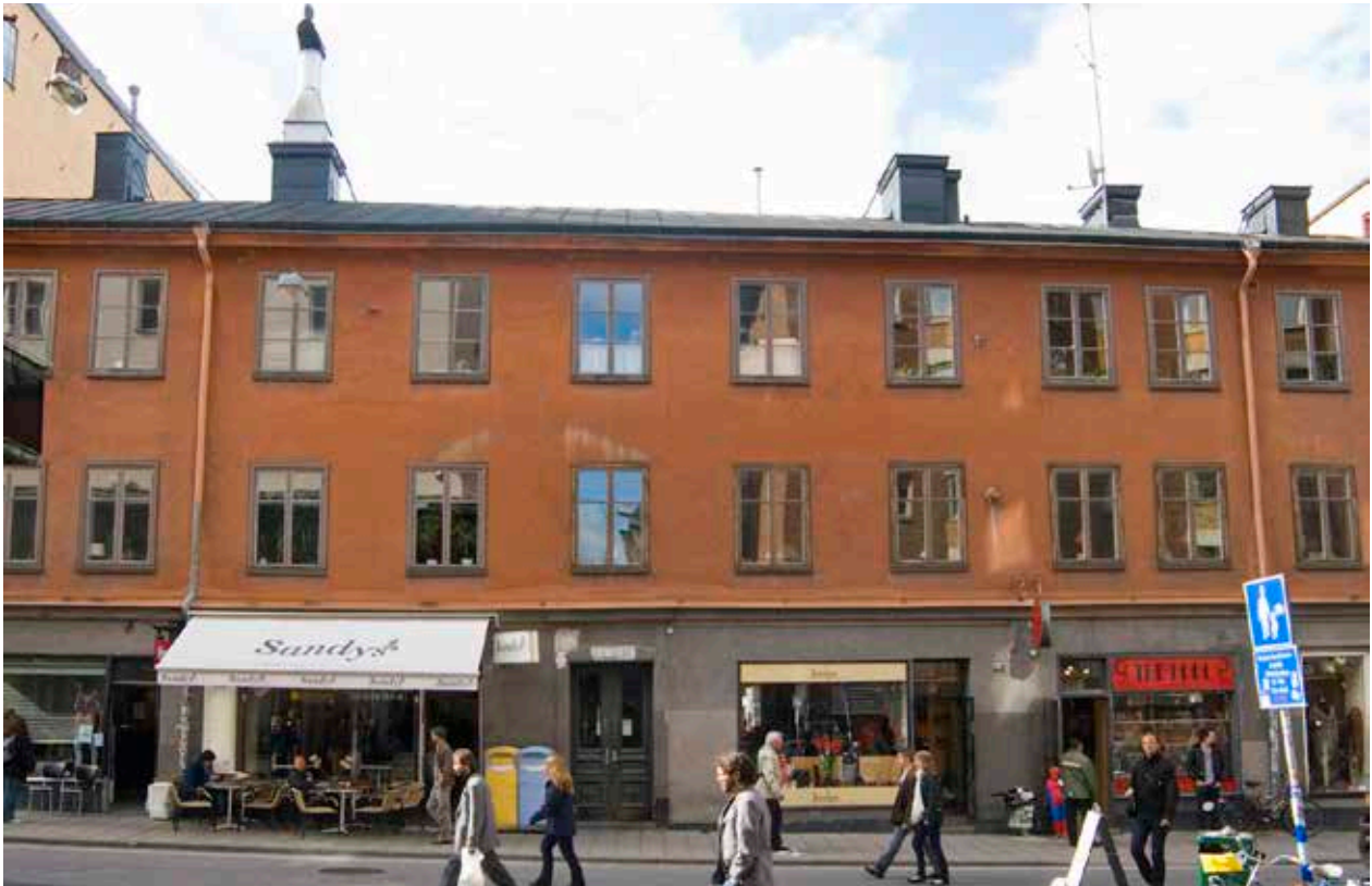
HUS 1. FASADEN MOT GÖTGATAN ÄR SLÄTPUTSAD MED FÖNSTER I MURLIVET. PORTEN HAR EN ENKEL OMFATTNING. FOTO: J. MALMBERG.
